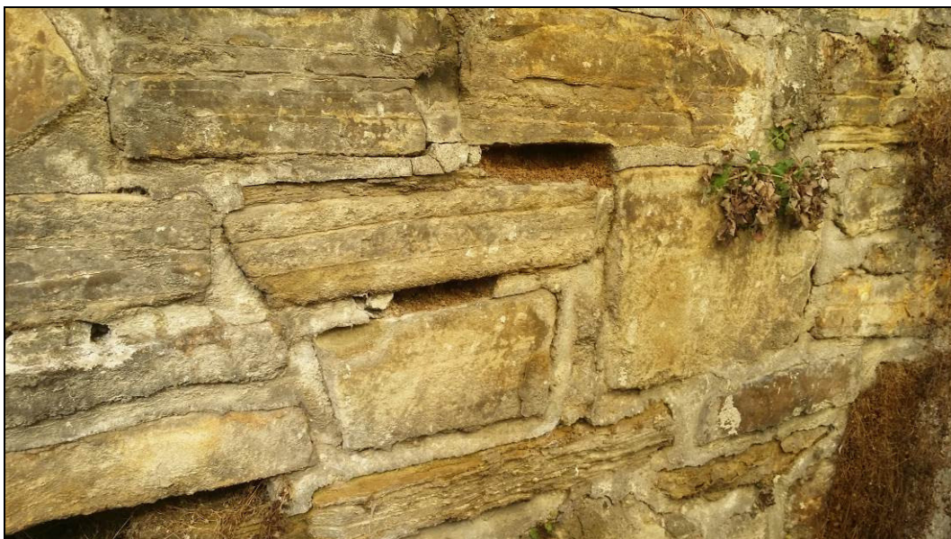
Obr. č. 4 Degradace spárování zdiva
